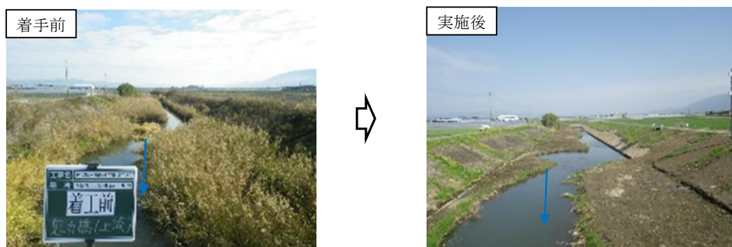
写真 4-3 陣屋川の堆積土砂撤去実施例
