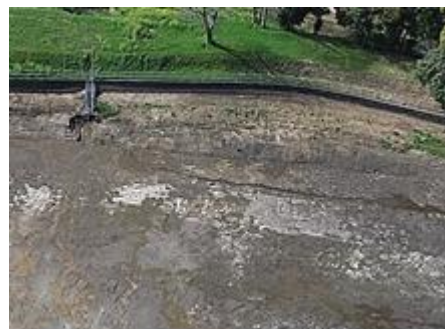
写真 4-5 ため池の堆積土砂撤去実施例
